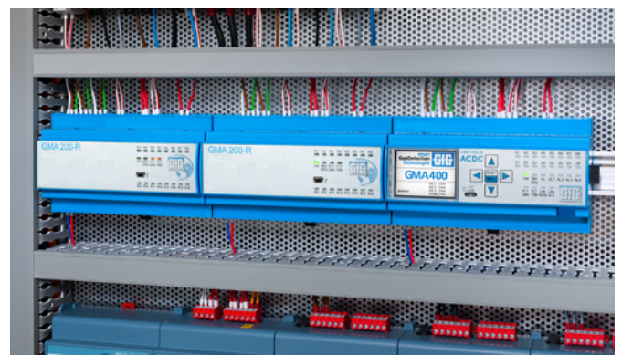
GMA400 mit zwei Relaismodulen GMA200-RT im Schaltschrankaufbau
